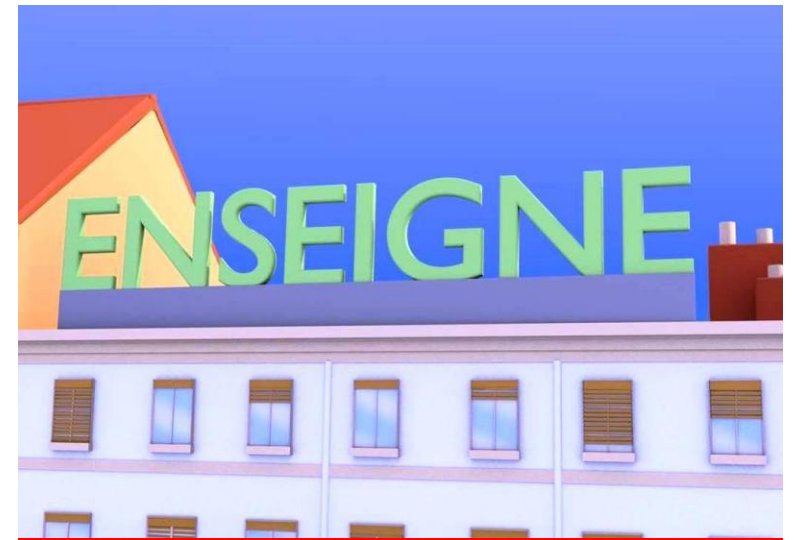
Enseigne en toiture : interdite
